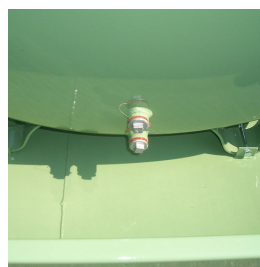
Scarico di fondo da 1" per le pulizie periodiche
